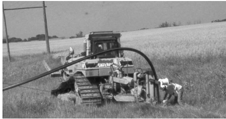
Rohl Construction installant la conduite PE100 au sud de Shoal Lake.
